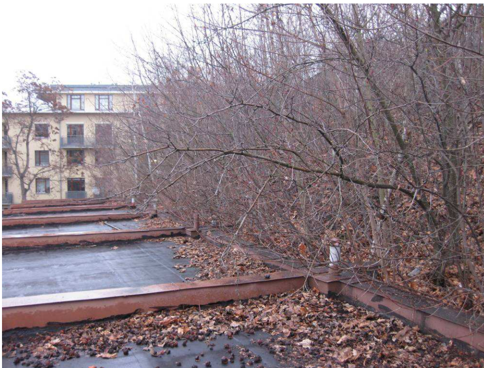
Kontakt garáží a zemního svahu
